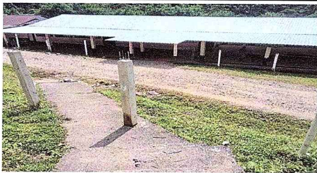
Foto 1: SUSTITUCION DE CAMBIO DE LAMINAS EN AULAS
