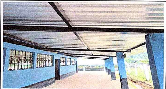
Foto 2: SUSTITUCION DE COSTANERAS Y CAMBIO DE LAMINAS A CORREDOR
