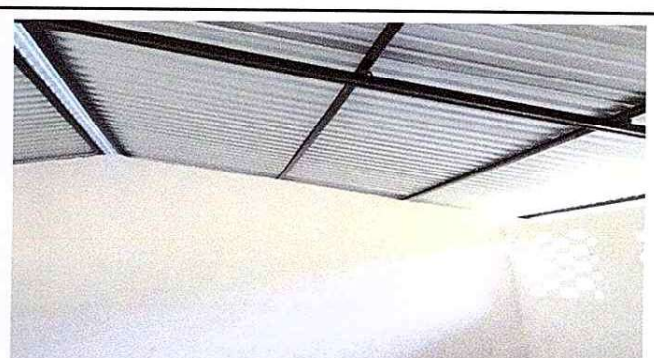
Foto 4: REPELLO DE PAREDES DE CADA AULAS.
